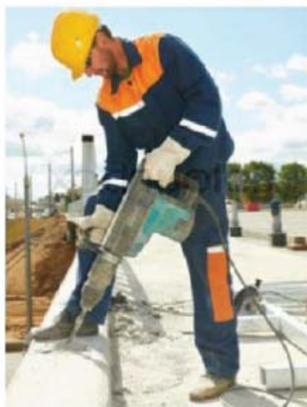
UN OPERAIO AL LAVORO IN UN CANTIERE
